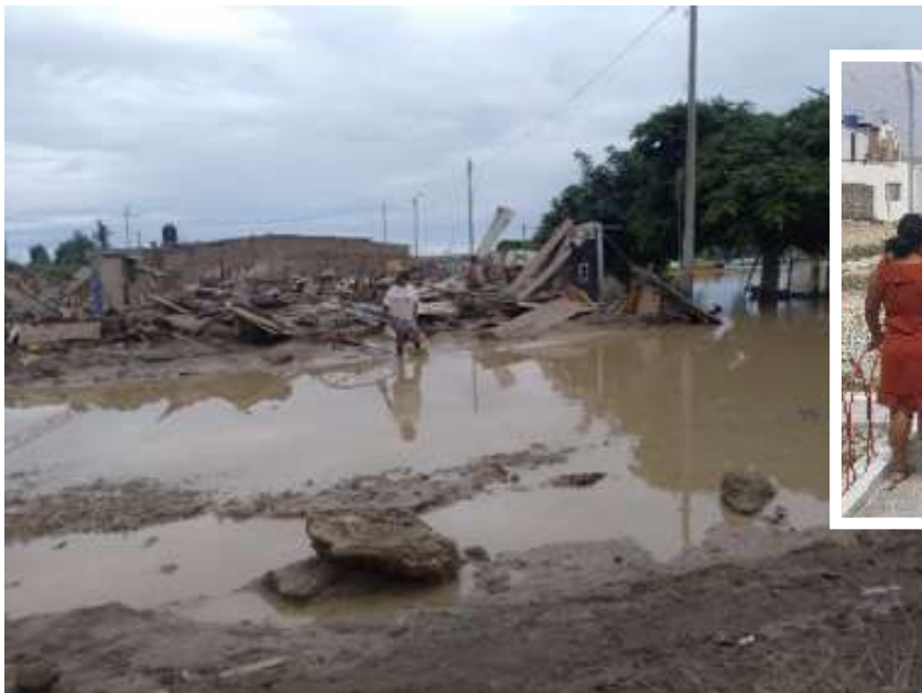
Imagen de algunas casas de Tahuantinsuyo, totalmente derruidas.
